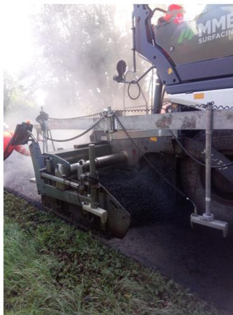
Hot Mix Asphalt
